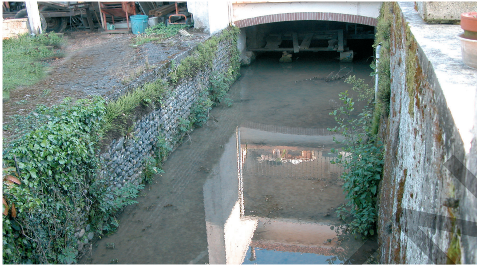
Le canal de fuite du moulin d'Os ».
