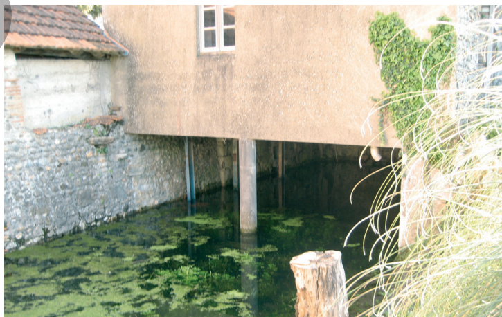
Moulin de Biron : boucau et canal de fuite
