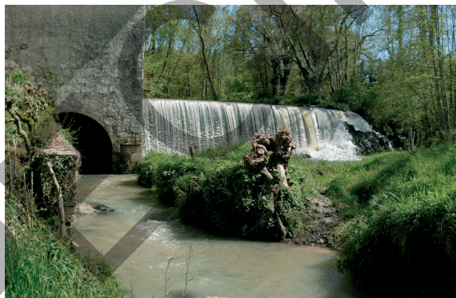
Le moulin de Lajous, son canal de fuite et la chute d'eau de son barrage.
