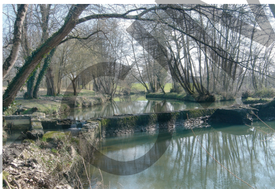
Les biefs du moulin de Mounicq.
