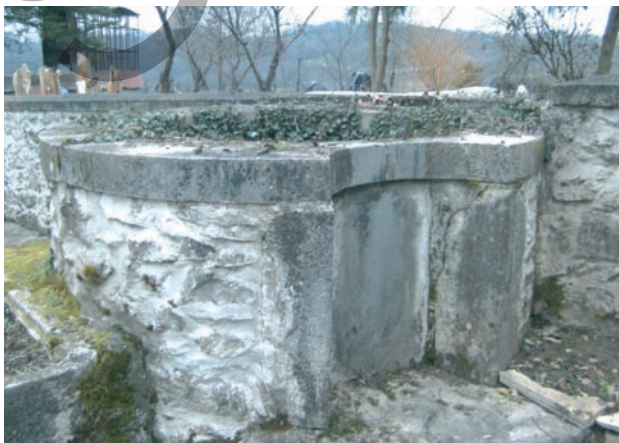
● Puits à margelle.
