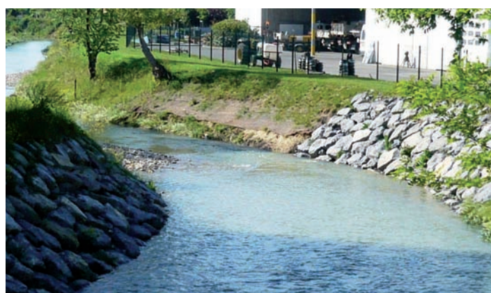
Renforcement des berges du Luzoué.
