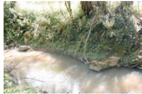
Vestiges du barrage Maysou
