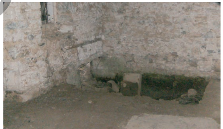
L'intérieur de la maison Godelimac.
