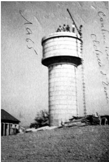
Château d'eau de Montestrucq.
