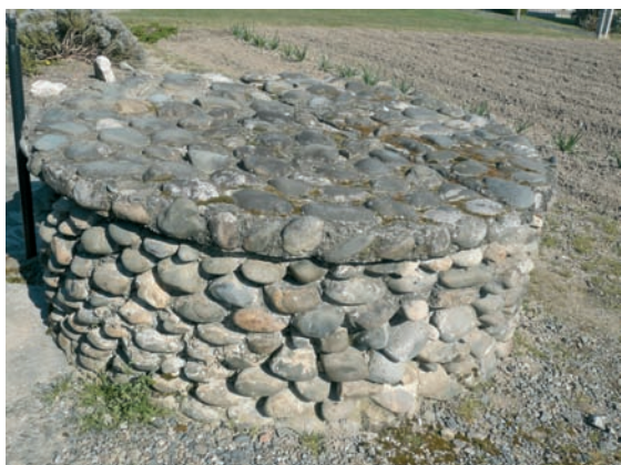
Le Puits de Mongelous, entièrement réalisé en galets du gave.
