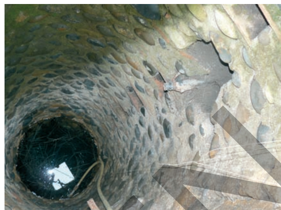
Les excavations pour descendre et nettoyer.
