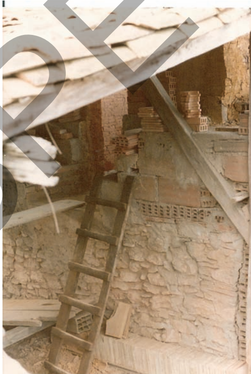
● Des échafaudages ou des échelles permettent les accès aux différents niveaux de la chambre du four.
