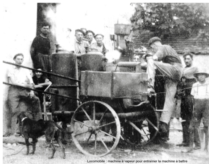
Locomotive : machine à vapeur pour entraîner la machine à battre
