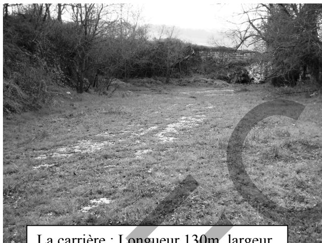
La carrière : Longueur 130m, largeur 40m, hauteur du front de taille 7m.
