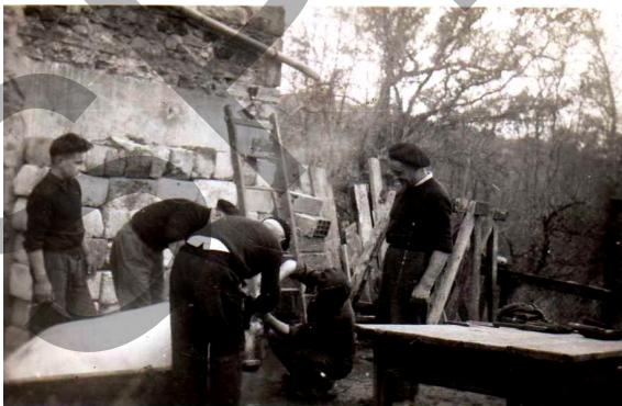
La pèlere chez Jean-Baptiste Laplace charpentier à Viellesègure
